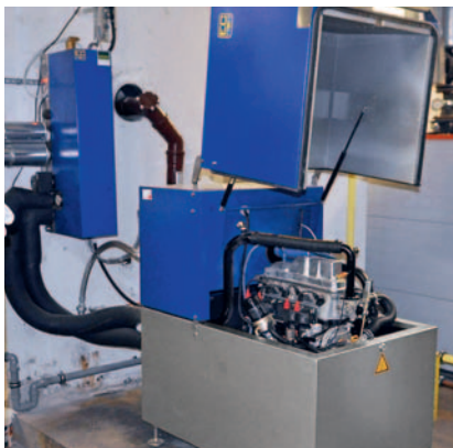
Bilder: Siemens Passt zur Grundlast der Liegenschaft: BHKW-Modul der dänischen EC Power
