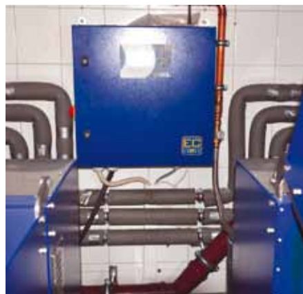
Im Steuerschrank werden entsprechend dem Wunsch des Kunden die drei möglichen Betriebsstrategien für das BHKW programmiert: wärmegeführt, stromoptimiert oder aber tarifgeführt.
