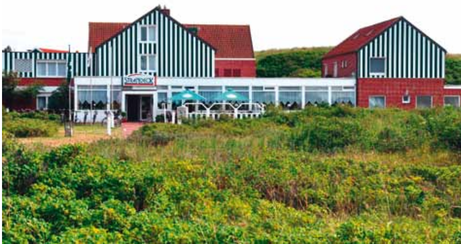
Dünenhotel Strandeck, 10 m ü. M.: Hier wurden zwei BHKW mit einer Wärmepumpe kombiniert.
