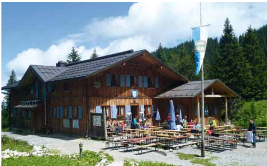
Tutzinger Hütte, 1327 m ü. M.: Die Kombination von Photovoltaik und BHKW sorgt für Komfort.
