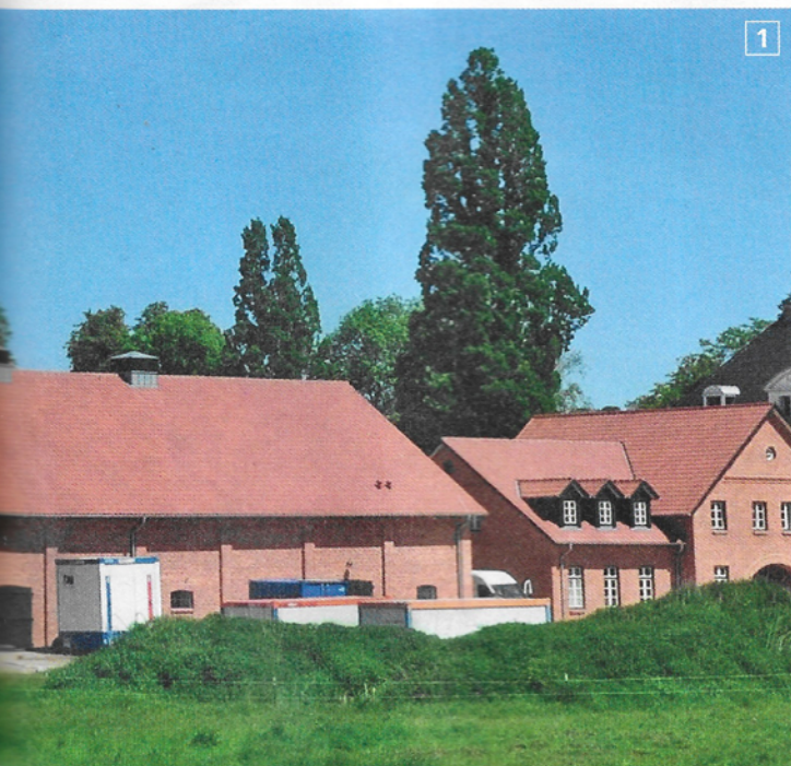
1 Gut Rothensande (Immenhof) in Malente. Die Technikzentrale befindet sich im ersten Stock des scheunenartigen, langen Gebäudes mit den beiden Kaminaufsätzen.
