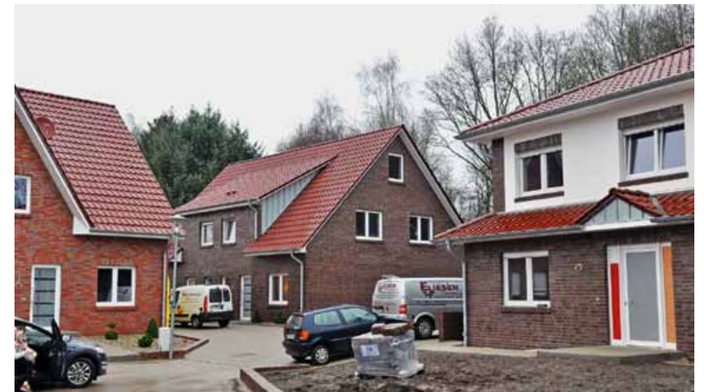
Wohnanlage Runnebaum, Damme. Das BHKW als KfW-70-Ausgleichsmaßnahme im zentralen Heizungskeller des Nahwärmeverbunds entbindet von einem übermäßigem Wärmeschutz der einzelnen Häuser
