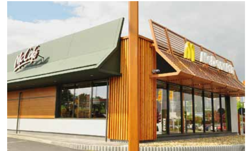
Im McDrive in Weißig bei Dresden beliefert das BHKW die Klimaanlage mit Nahwärme
