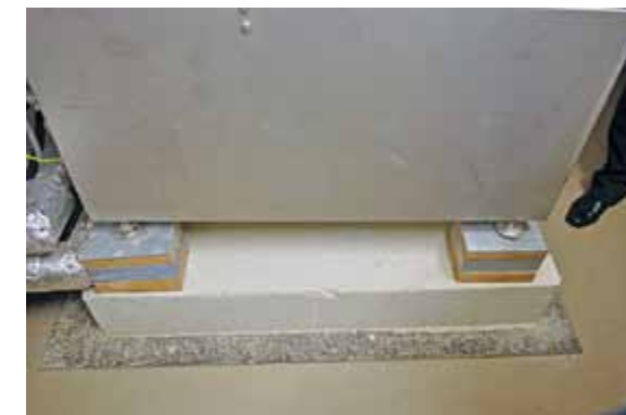
Aufbau Vibrationsdämmung mit Schwingmetallen und Betonsockel (Masse)
