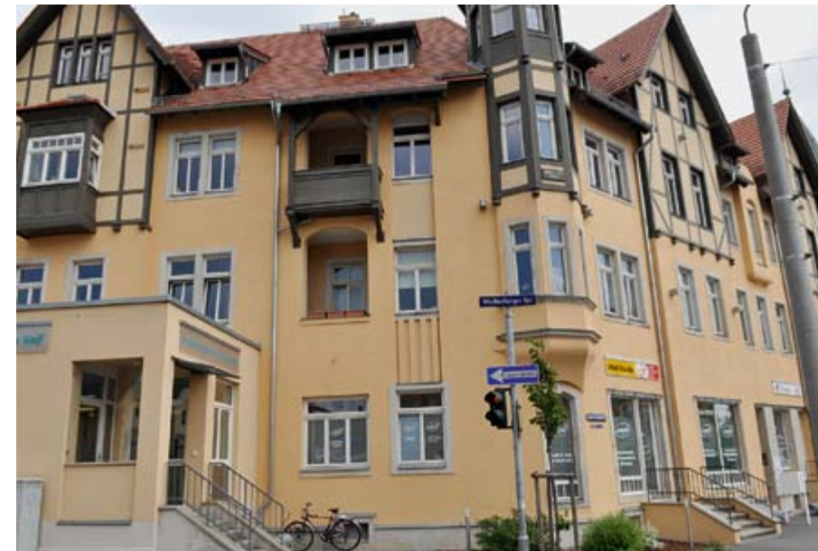
Wohn-Immobilie Bautzner Landstraße, Dresden. BHKW-Strom für die Mieter
