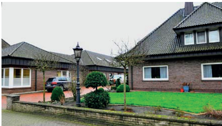
XRG-versorgtes Wohnhaus und Betriebsgebäude Franz Lübbehusen GmbH
