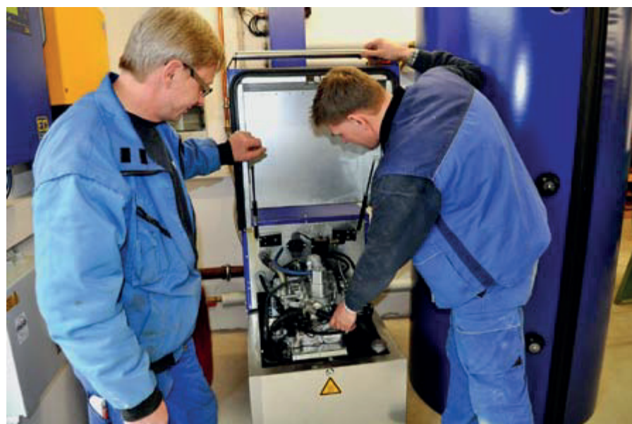
Thomas Lübbehusen (links) mit Mitarbeiter am XRGI 6. Das Herzstück aller vier XRGI-Modelle (von 6 bis 20 kW elektrisch) bilden Modifizierungen der bewährten Motoren von Toyota, die sowohl für Erdgas als auch für Flüssiggas konfiguriert werden können und die besonders lange Wartungsintervalle anbieten
