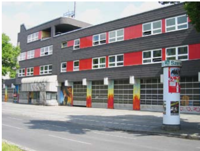
KWK in der Feuerwache Berlin-Kreuzberg. Dusch- und Waschwasser gewährleisten den ganzjährigen Wärmebedarf
