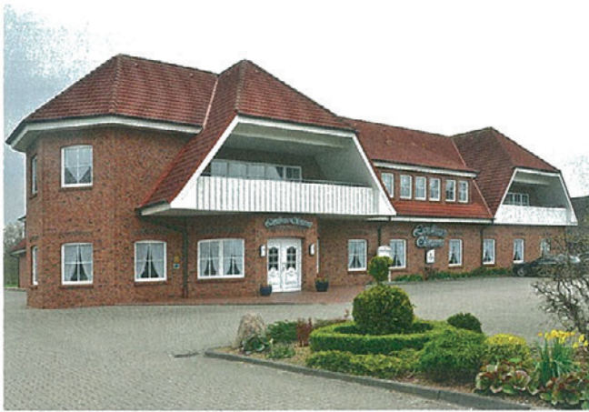
Das „Landhaus Oltmanns“ im ostfriesischen Neermoor wird von einer KWK-Anlage beheizt, die mit einem Brennwertkessel kombiniert wird.
