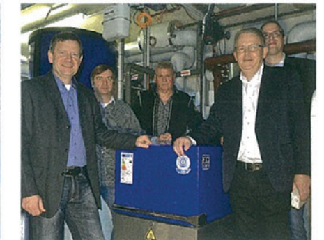
Gemeinsamer Erfolg im Heizraum (v.l.n.r.): Energieberater Carsten Mücke, Hotelbetreiber Christian Oltmanns, Heizungsbauer Egon Peters, Hermann Wilken von Cordes & Graefe in Emden sowie Daniel Norder, der für Brötje im Außendienst arbeitet.
