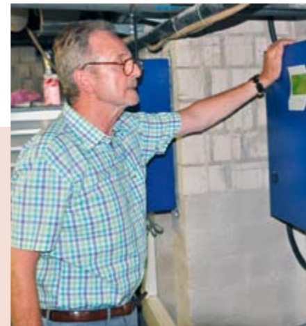
Hotelier Harm Freese kontrolliert die Betriebsstunden
