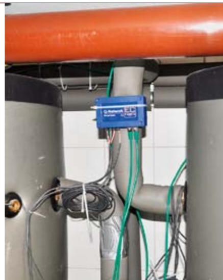
Die Q-Network-Box mit Temperaturfühlern für den/die Wärmespeicher ist im Standard-Lieferumfang enthalten und erleichtert die Einbeziehung vorhandener Puffersysteme sowie den nachträglichen Einbau eines XRGI-Systems in eine bestehende Heizzentrale. Die rote Rohrleitung oberhalb der Box ist der Kaltluftkanal von der Wärmepumpe zum Betriebsraum
